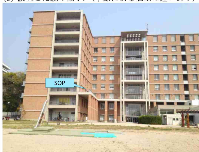
(c) SOP を設置した建物
