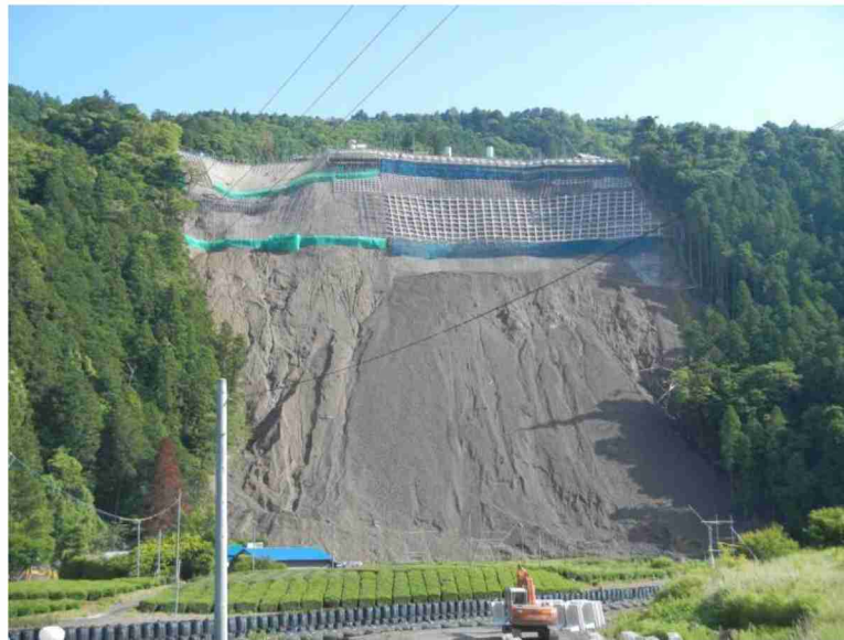
(c) 崩壊した斜面の補強工事例
