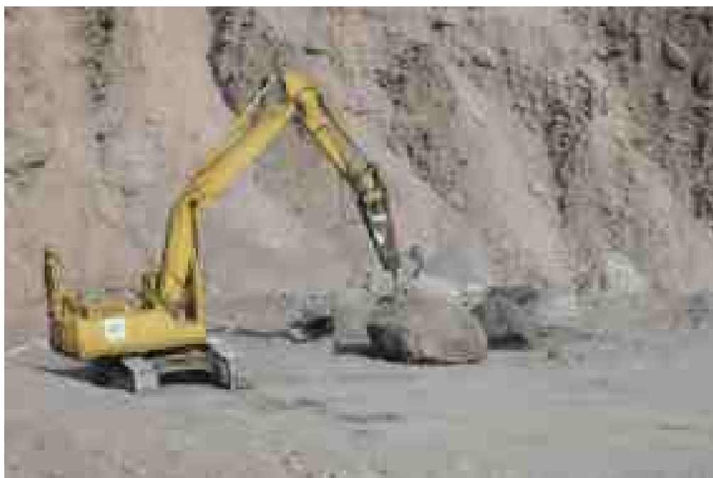
図-6.3.6 無人化施工における割岩状況
