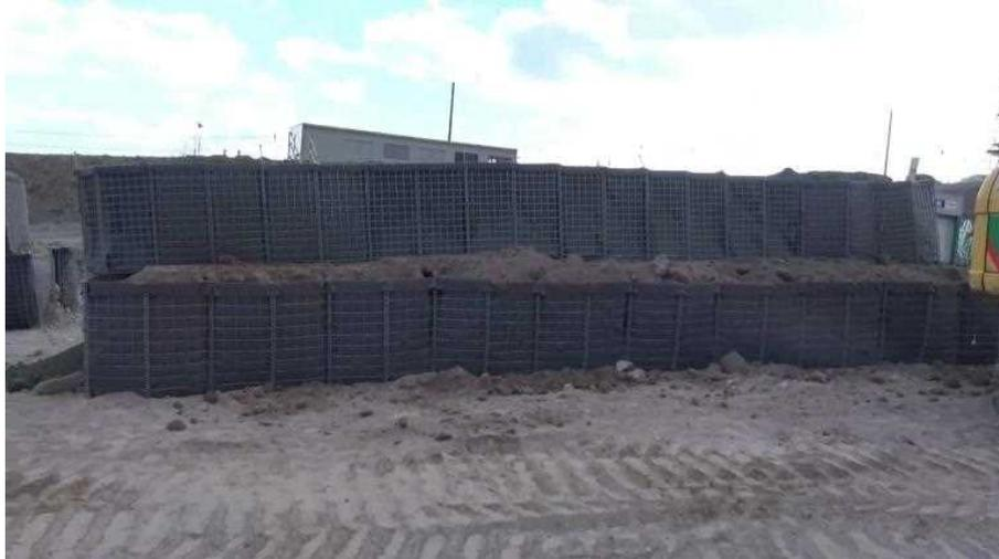
写真 6.3.1-6 連続土嚢 2 段積み遠隔施工出来形-2
