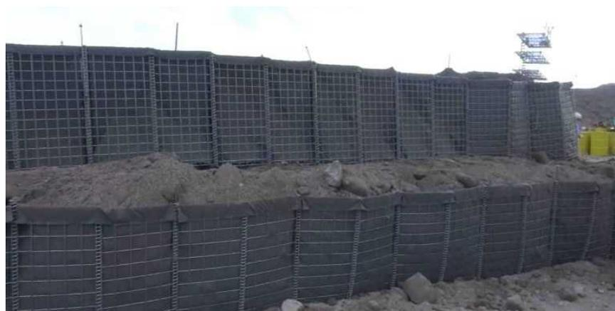
写真 6.3.1-5 連続土嚢 2 段積み遠隔施工出来形-1
