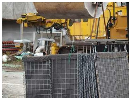
写真 6.3.1-4 土嚢設置治具装着状況
