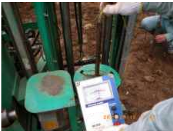
写真-4.2.5 地下水位測定状況
