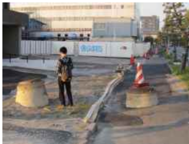
(2) マンホールの浮上
