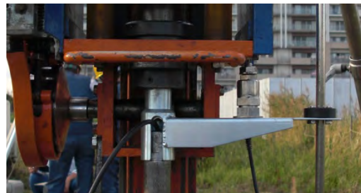
写真-3.3.8 トリガーの設置状況
