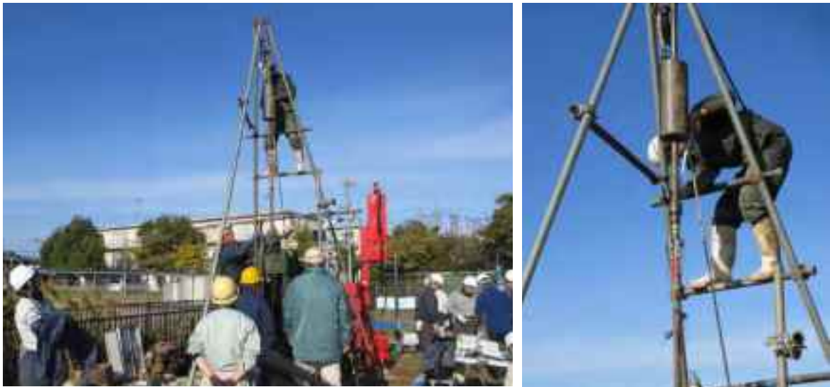
写真-3. 4. 6 Test 9 (SPT)の計測風景
