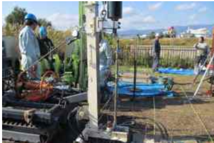
写真-3. 4. 3 Test 1 (Ramda)の計測風景
