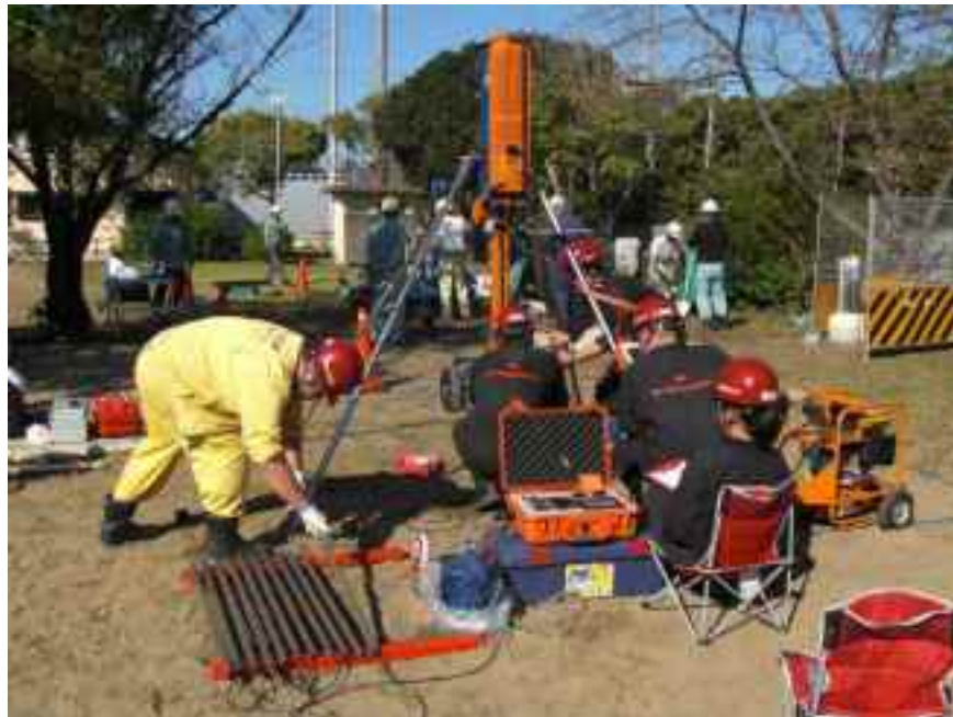
写真-3.3.11 PDC の試験状況 (茨城県神栖市掘割)
