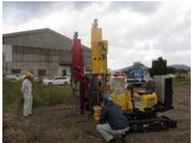
写真-3.2.9 唐津市岸山の試験状況
