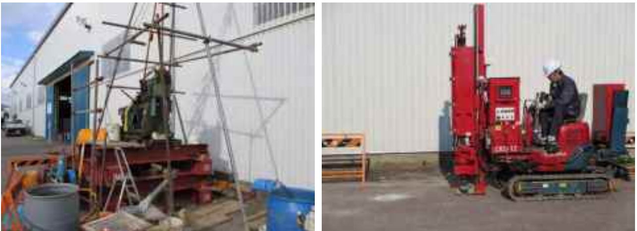
写真-3.2.3 浦安市鉄鋼通りでの試験状況
