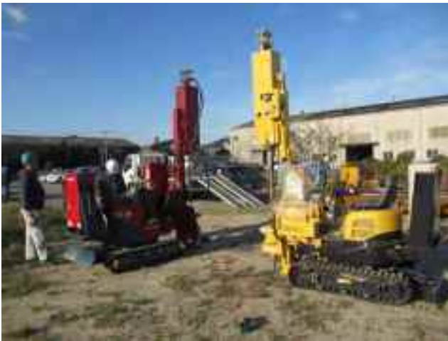
写真-3.2.8 唐津市原の試験状況
