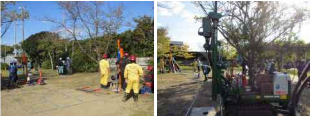
写真-3.2.2 神栖市掘割での試験状況
