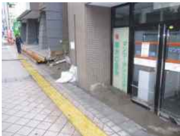
(1) 建物の抜け上がりと沈下
