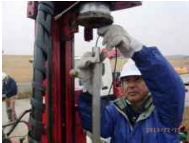
(a) マイク線引出し用治具の設置
