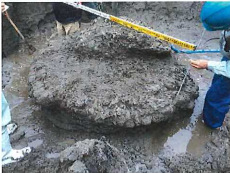
写真-1 注入孔 (T-4) の掘り起こし状況
