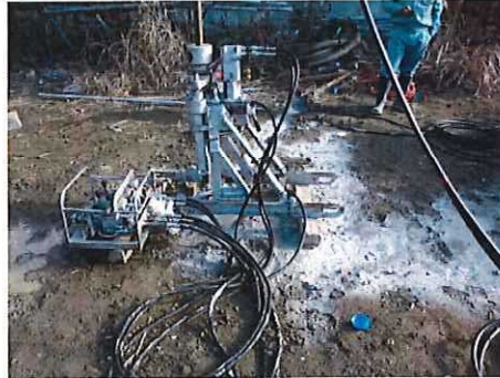
写真-3 小型注入機による注入状況
