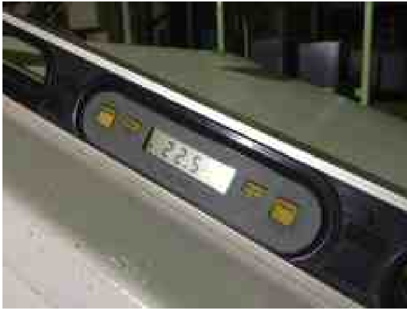
写真 7.4.1-6 角度計確認状況
