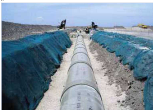
Fig. i 埋設工事風景
