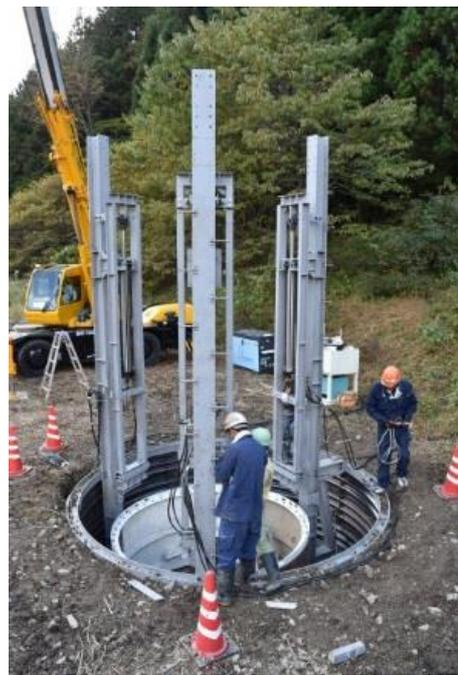
図 26 反力架台設置完了
