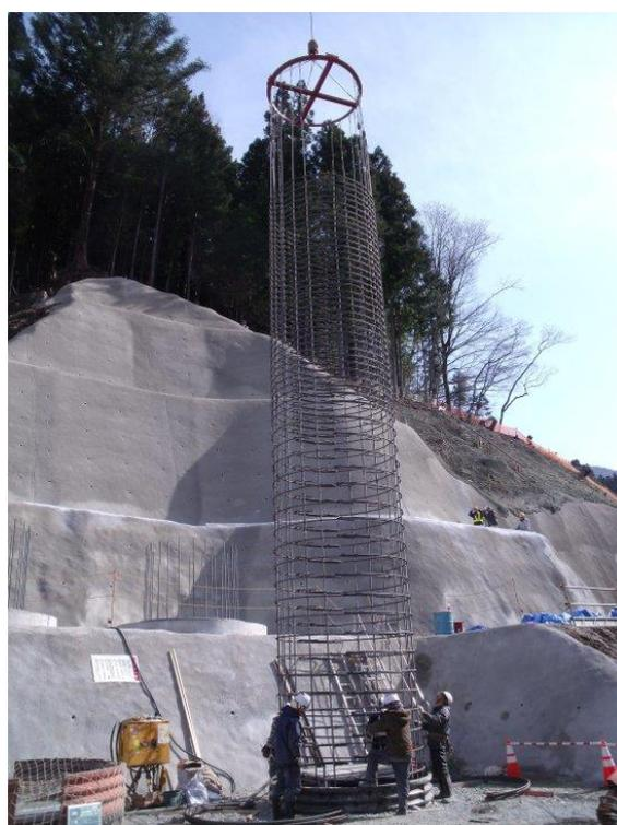
図 30 鉄筋籠組立完了（一部を除く）
