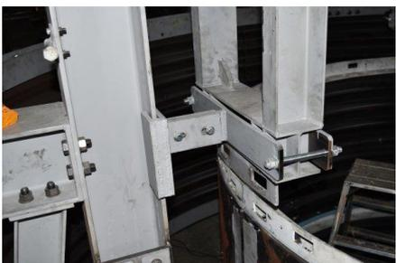
図22 枠形支柱の改良 (上部・下部)
