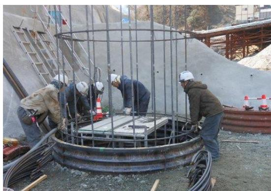
図 29 杭頭孔外でのフープ筋の取付状況
