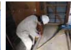
貫入試験による木材の強度推定
