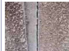
シーリング材のはく離
