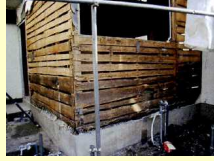
仕上げ材が解体された状態で行う劣化調査
