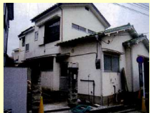
解体工事着手前に行う現況調査
