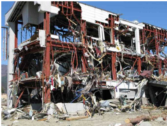
津波による外装材の流失 (岩手県陸前高田市)
