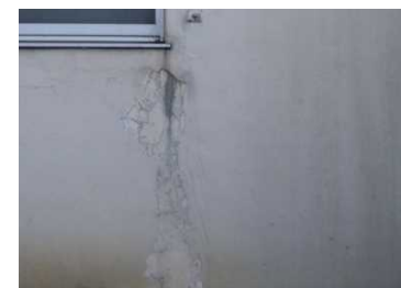
写真1 塗り仕上げのはがれ
