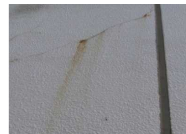
写真3 ひび割れからの錆汚れ
