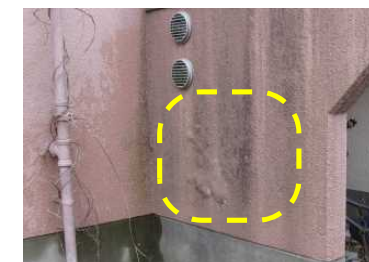
写真2 塗り仕上げのふくれ
