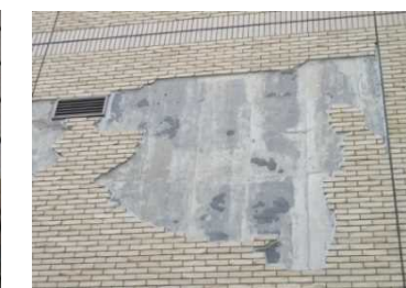
写真6 タイルの剥落
