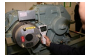
巻上機に貼り付けられたRFIDタグからのデータ読み取り(タグリーダー)
