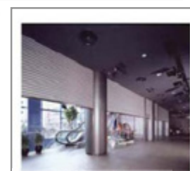
電動シャッター
