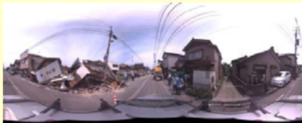
360度カメラによる被害状況分析
