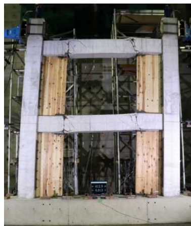
RC造ラーメン骨組+ CLT袖壁の部分架構実験
