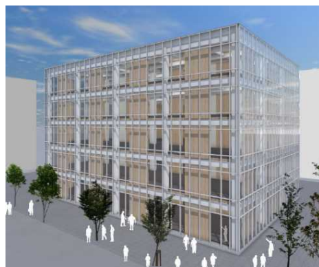
タイプⅠ (RCメガ + 木2層) タイプⅡ (各階S + CLT壁) 事務所建築試設計例
