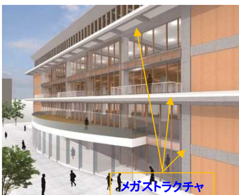
タイプⅠ (RCメガ + 木2層) タイプⅡ (各階S + CLT壁) 事務所建築試設計例
