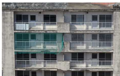
【実態調査例】 主な中性化深さ：○ かぶり剥離：至所× 露筋：所々×
