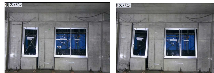
実大5層実験における窓枠の検証例
