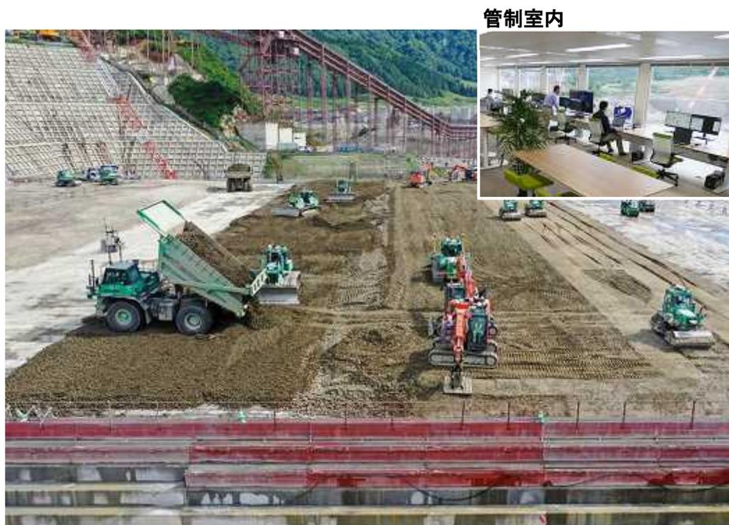
A<sup>4</sup>CSELの自動化建設機械が連携して堤体打設を行う様子
