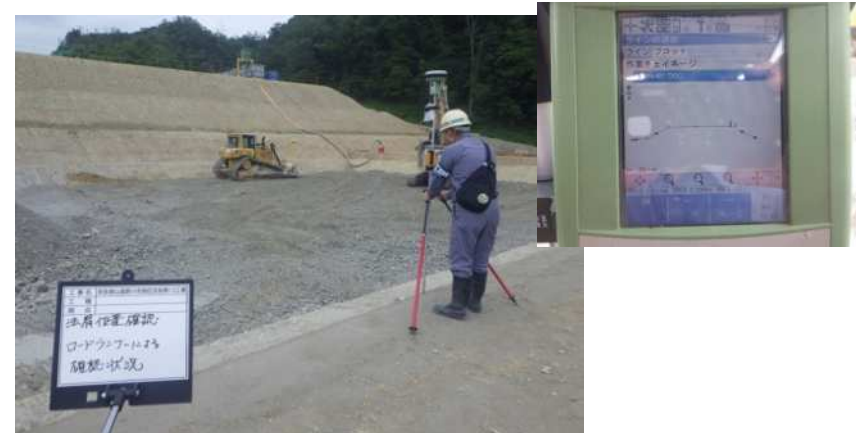
GNSSローバーによる出来形確認
