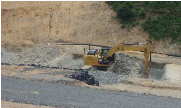
マシンガイダンスバックホウによる作業状況
