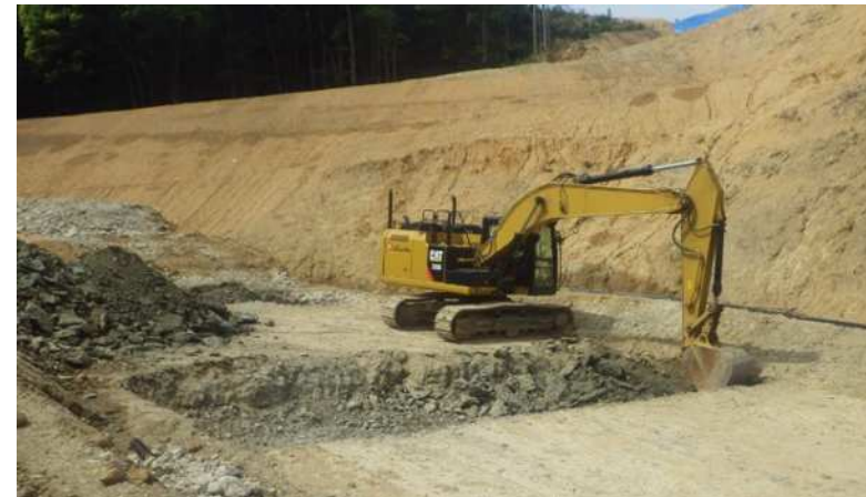
マシンガイダンスバックホウによる作業状況
