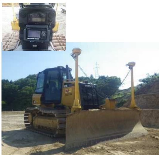
MCブルドーザー (盛土撒き出し・敷き均し)
