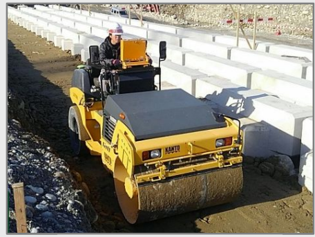
GNSSを用いた締固め作業
