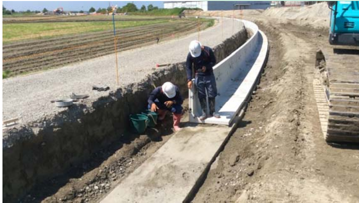
敷モルタル高さ確認状況
