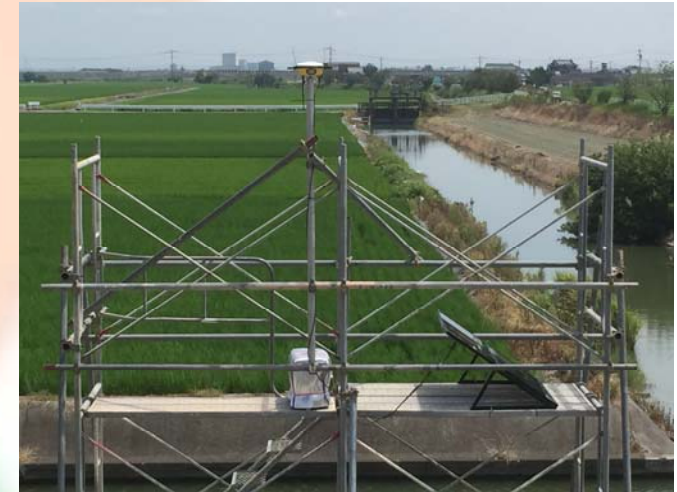
固定足場を設置した事例
