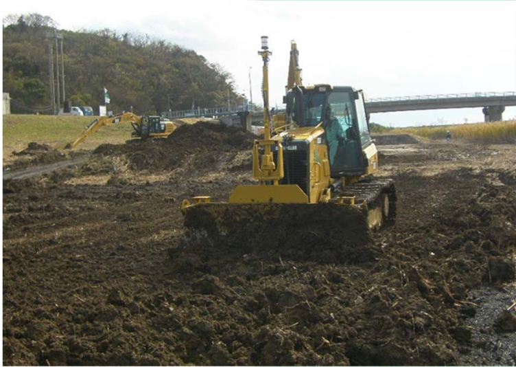
ブルドーザーによるマシンコントロール
