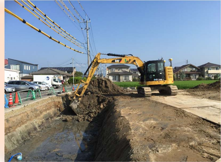
バックホウによるマシンガイダンス
