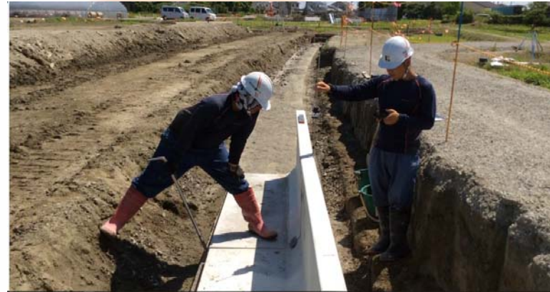
L型擁壁施工状況
