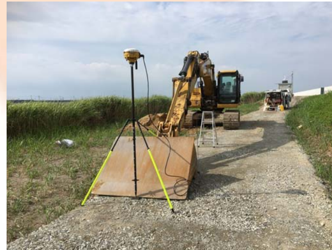
キャリブレーション実施状況
