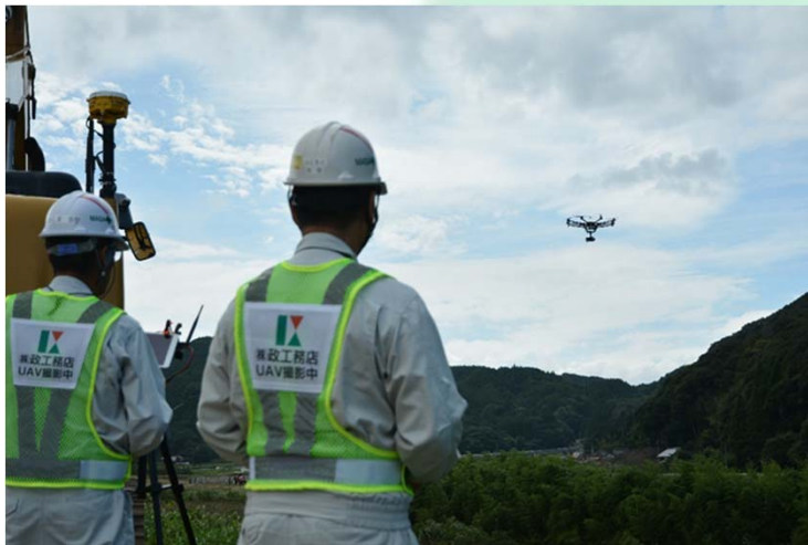
UAVによる3次元測量状況 (空中写真測量)
