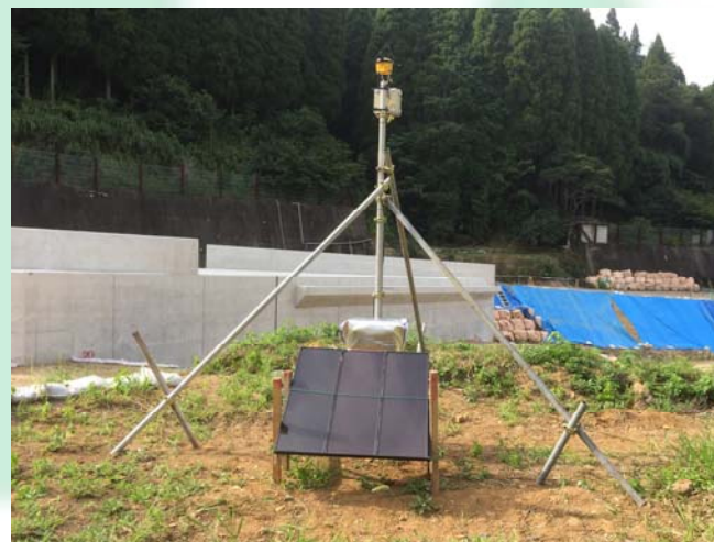
太陽光パネルを採用した事例
