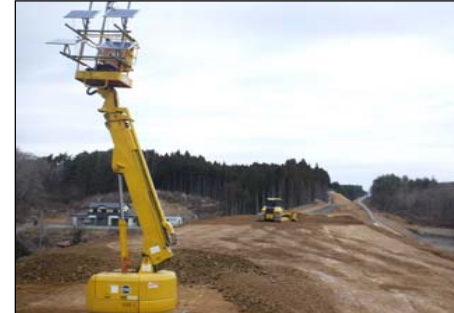
高所作業車へ取付け、移動可能にしました
