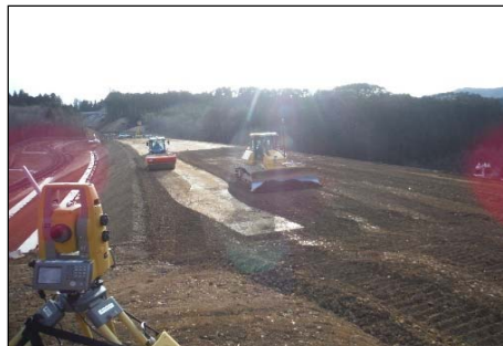
3DMCブルドーザーとGNSSを用いた締固め管理での盛土
