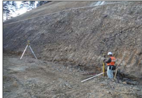
3次元設計データを利用した側溝の丁張り設置状況
