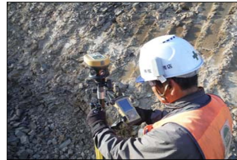
3次元設計データを利用した側溝の丁張り設置状況
