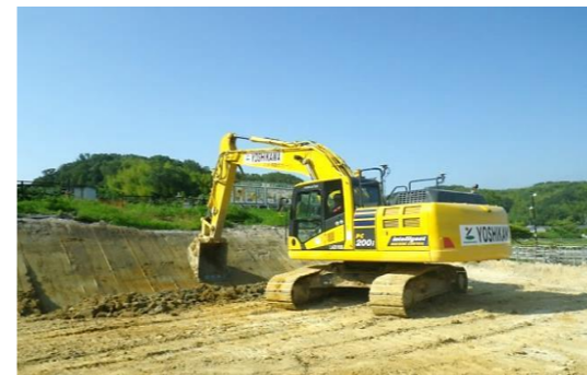
③ ICT建設機械による施工 (3次元マシンコントロールバックホウ)
