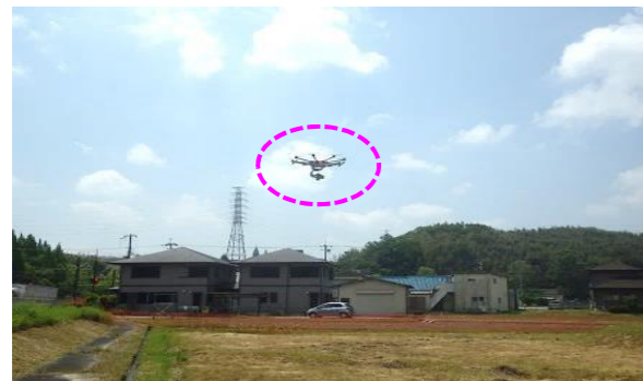
① UAVによる3次元起工測量
