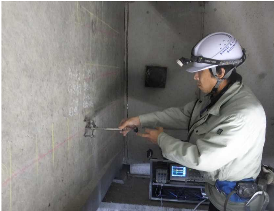
コンクリート構造物中の内部欠陥調査の例 (プレストレストコンクリート構造物の グラウト充填調査)
