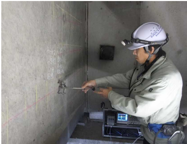
PC橋梁のグラウト充填調査
