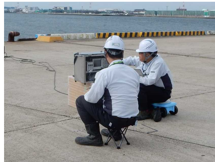
RC栈橋のコンクリート床版の浮き・ひび割れ調査
