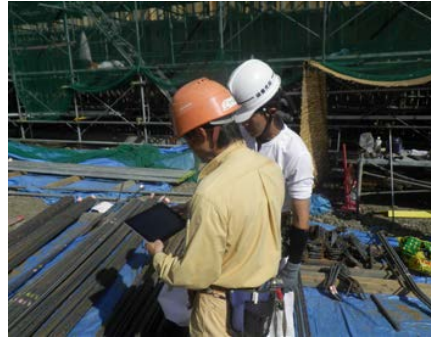
図 9 作業員と施工の確認
