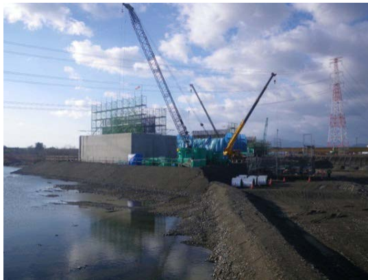
写真 1 O-P6 施工状況
