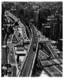
連続立体交差事業
