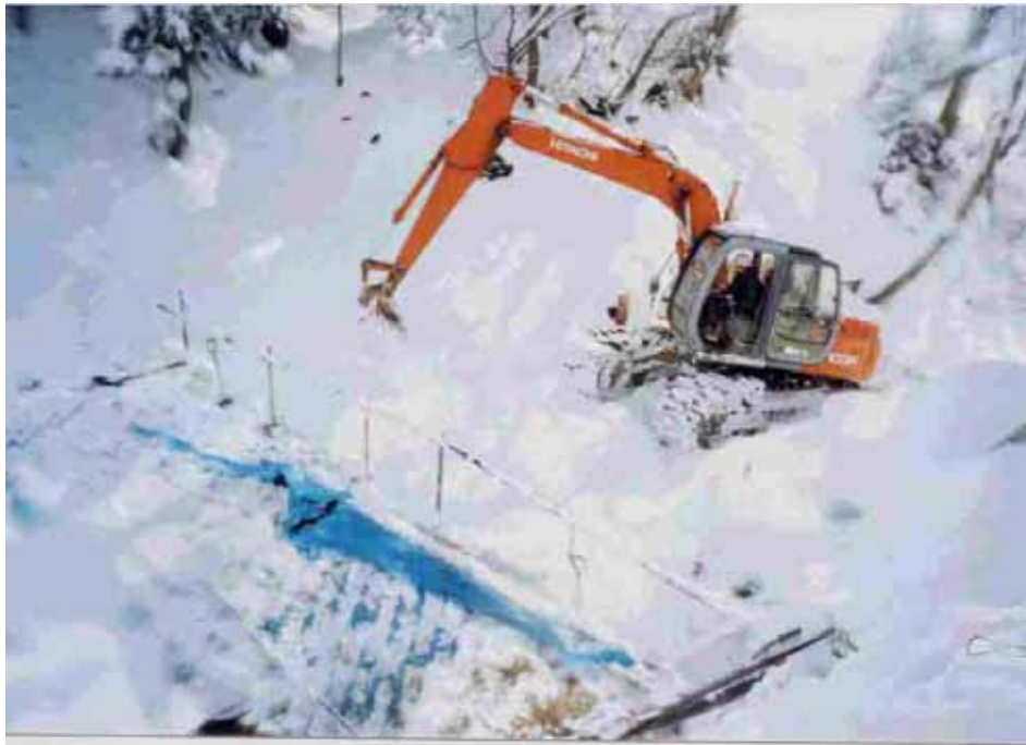
人力除雪後、バックホウにて処理
