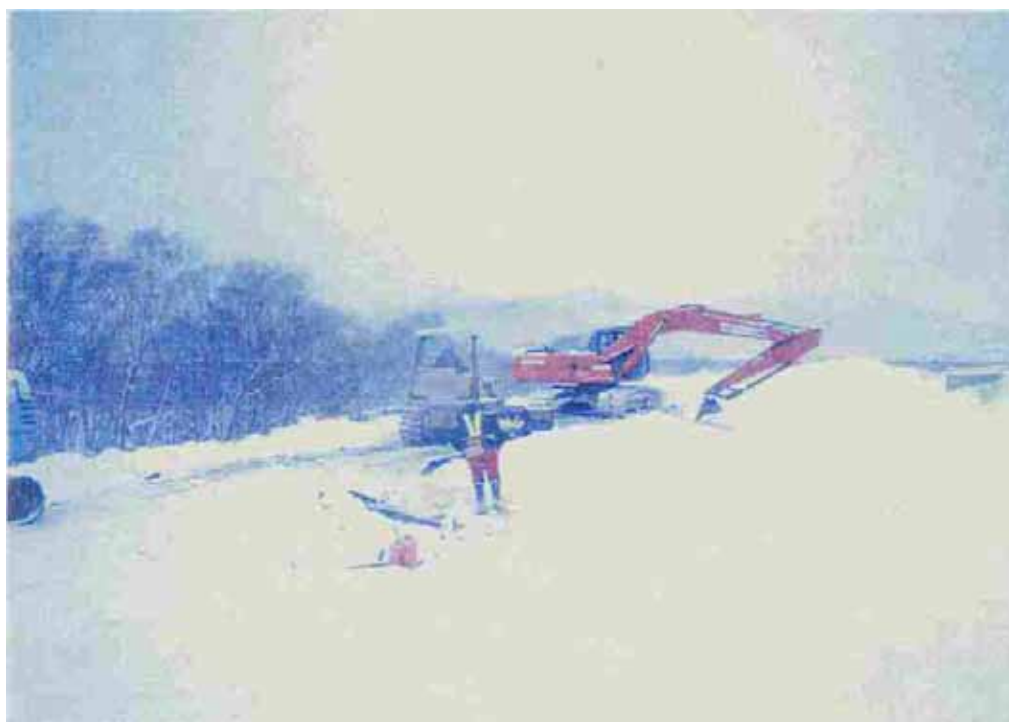
バックホウ、人力による施工箇所の除雪
