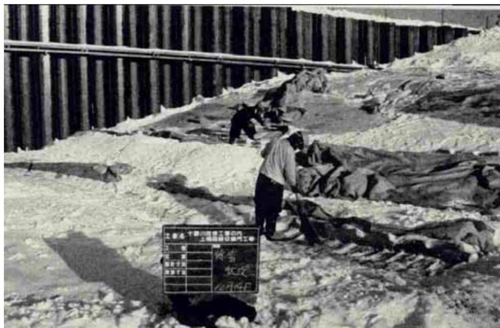
構造物をシート養生して除雪作業を容易にする
