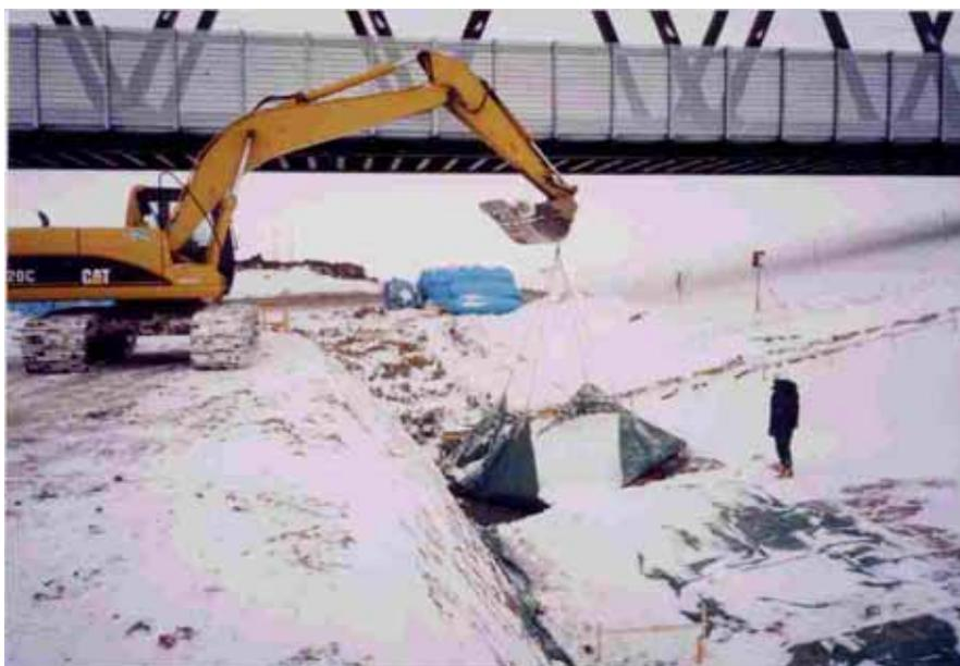
耐吊荷重用補強シートによる除雪
