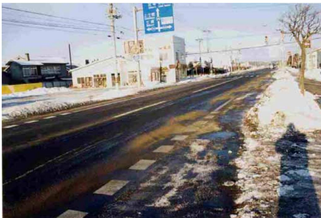
除雪後の湿潤部分への塩カル・砂散布によるスリップ対策
