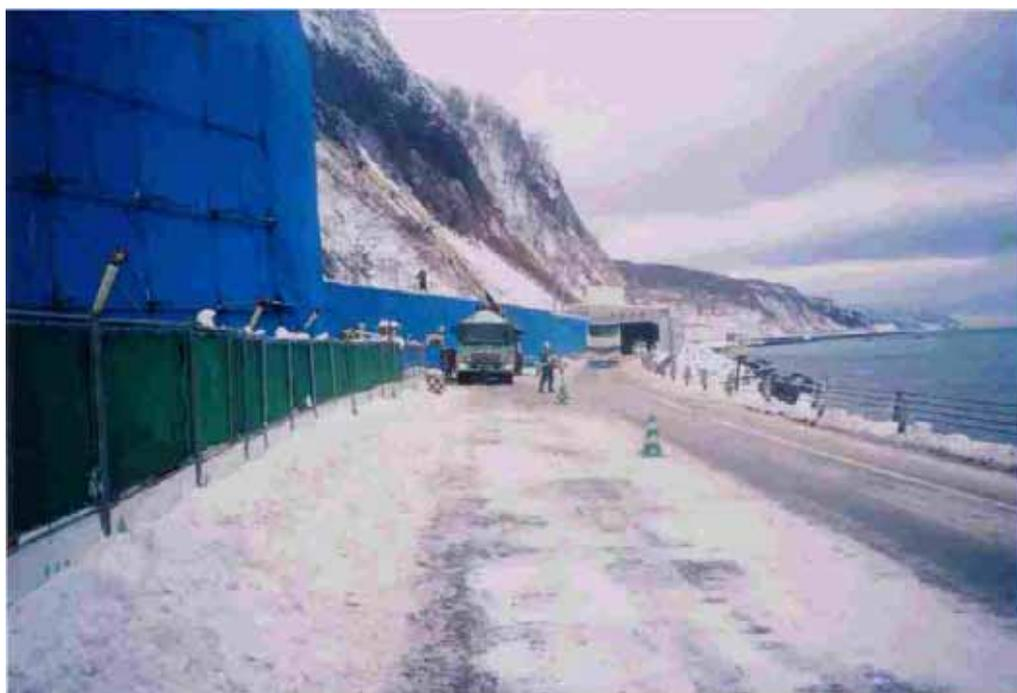
片側交互規制の状況（左手の堆雪スペースを除雪して幅員を確保する）
