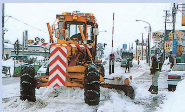
除雪グレーダによるかき出し作業
