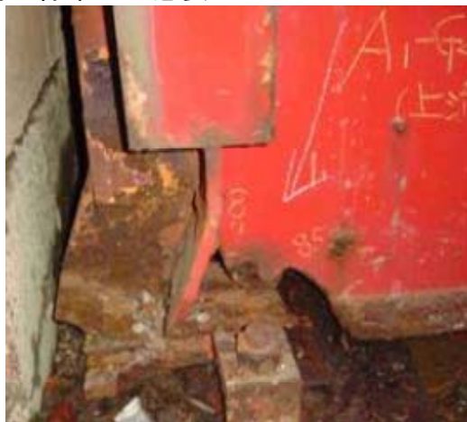
鋼橋桁端部の腐食損傷事例
