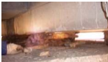
コンクリート橋桁端部の鋼材腐食事例
