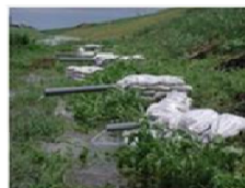
河川堤防の漏水
