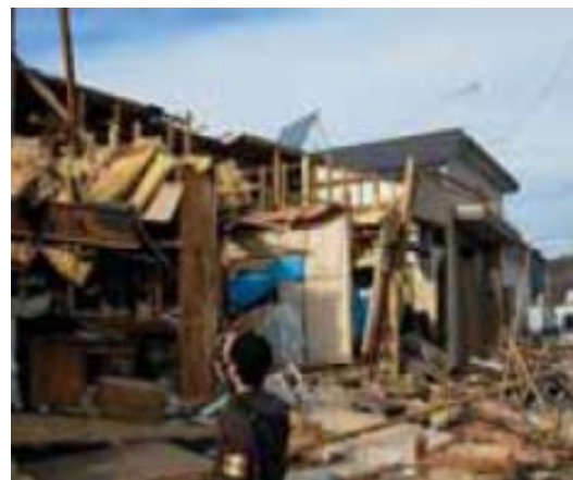
竜巻による屋根ふき材の損傷被害 (平成18年 北海道・佐呂間町)
