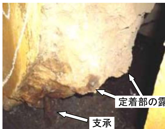
コンクリート道路橋桁端部の劣化事例
