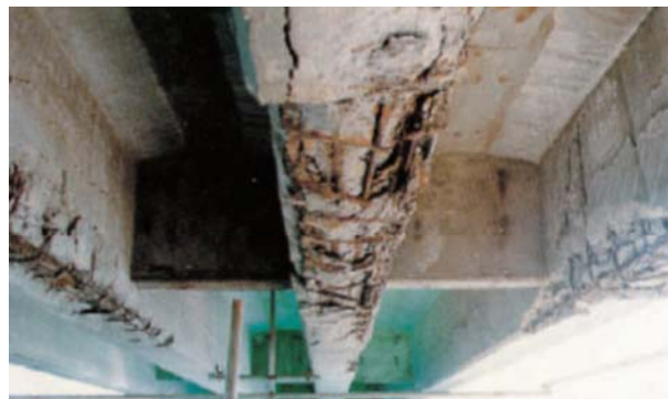
塩害環境下では橋梁が急激に劣化
