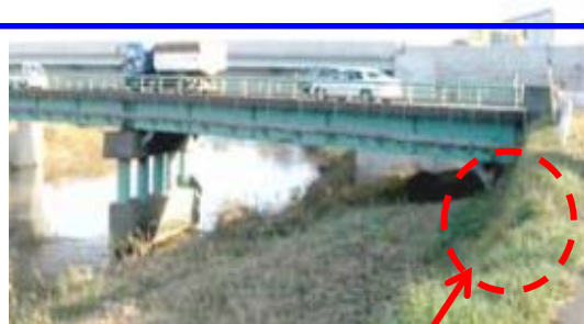
道路橋の桁端部
