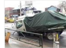
埋設管破損による道路陥没
