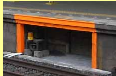
ホーム下の待避スペース
