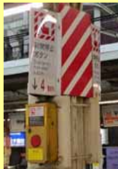
非常停止押しボタン
