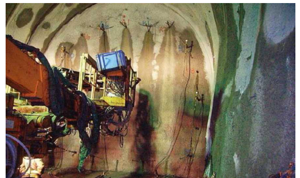
写真 薬液注入工の施工例
