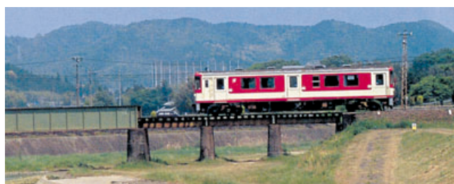
橋梁の変状、錆、劣化等
