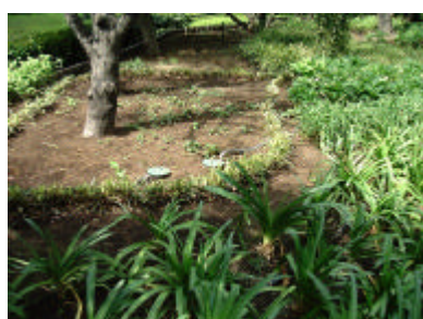
植栽に散水する設備
