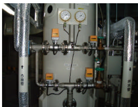
雨水・井水ろ過装置
