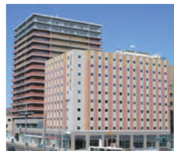
商業・住宅・宿泊機能を合わせ持ったツインタワー方式の複合商業ビル（従後）
