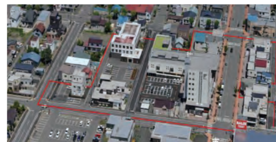
柔軟な地区設定（赤枠）で整備された施設建築物
