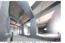
▲雨水貯留施設の内部
