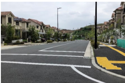
幹線道路における無電柱化
