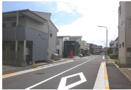
区画道路における無電柱化
