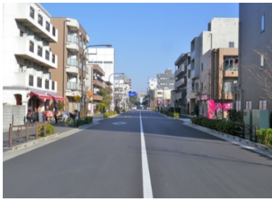
幹線道路における無電柱化
