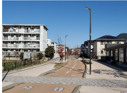
区画道路における無電柱化
