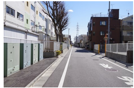
区画道路における無電柱化 学校敷地への地上機器の集約配置
