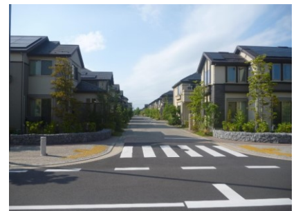
区画道路における無電柱化
