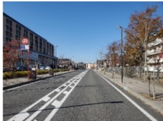
城野駅北土地区画整理事業 (福岡県北九州市)
