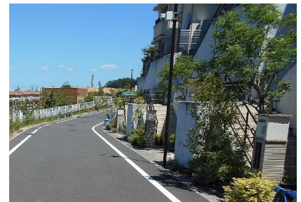
区画道路における無電柱化
