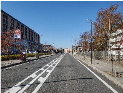
幹線道路における無電柱化
