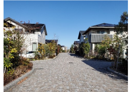
区画道路における無電柱化（二次開発にて）
