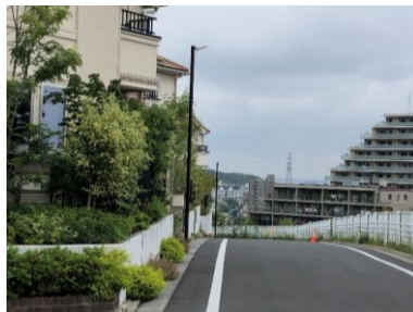
区画道路における無電柱化
