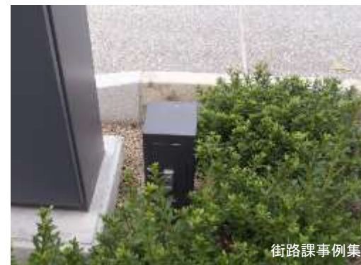
イベント用の電源設備
