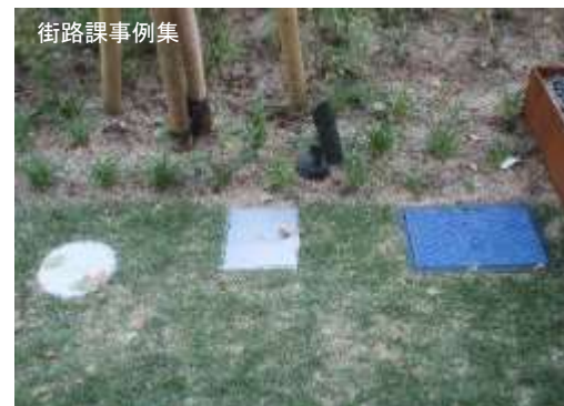
左から 排水・給水・散水 (水やり用)の設備
