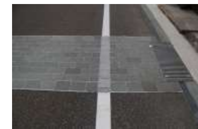
旧山陽道 宮市・国衛地区（防府市） 横断方向の石張り舗装によるイメージハンプの設置
