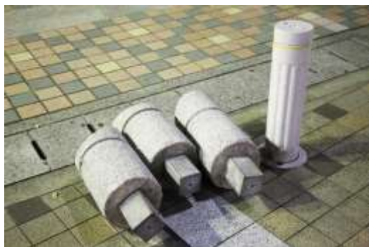
酒蔵通り (伊丹市) フラットな歩車道境界の歩道側に着脱可能なボラードを設置している
