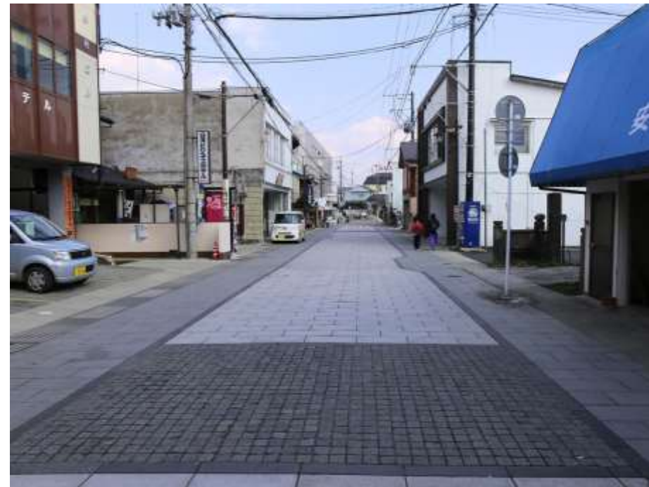
門前通り（白河市） 周囲と調和したピンコロ舗装によるハンプの設置
