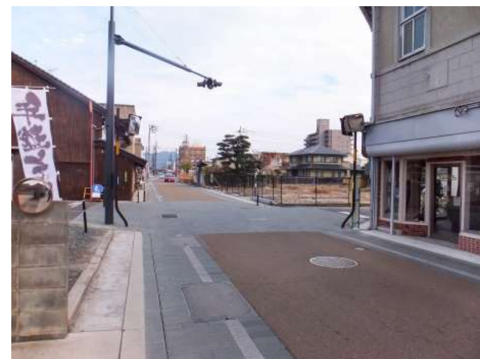
旧山陽道 宮市・国衛地区（防府市） 交差点部における石張り舗装によるイメージハンプの設置
