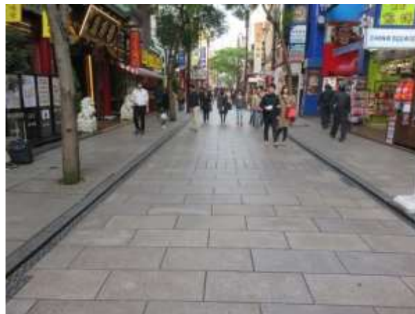
横浜中華街大通り（横浜市） 中国福建省産の御影石による石張り舗装
