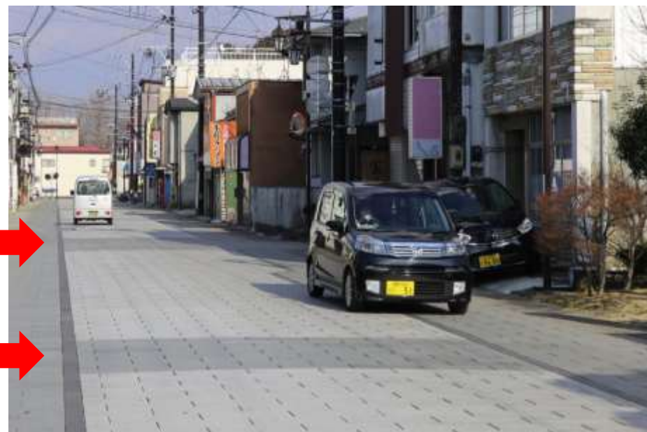
門前通り（白河市） 色味の異なる舗装材によるイメージハンプを等間隔で設置
