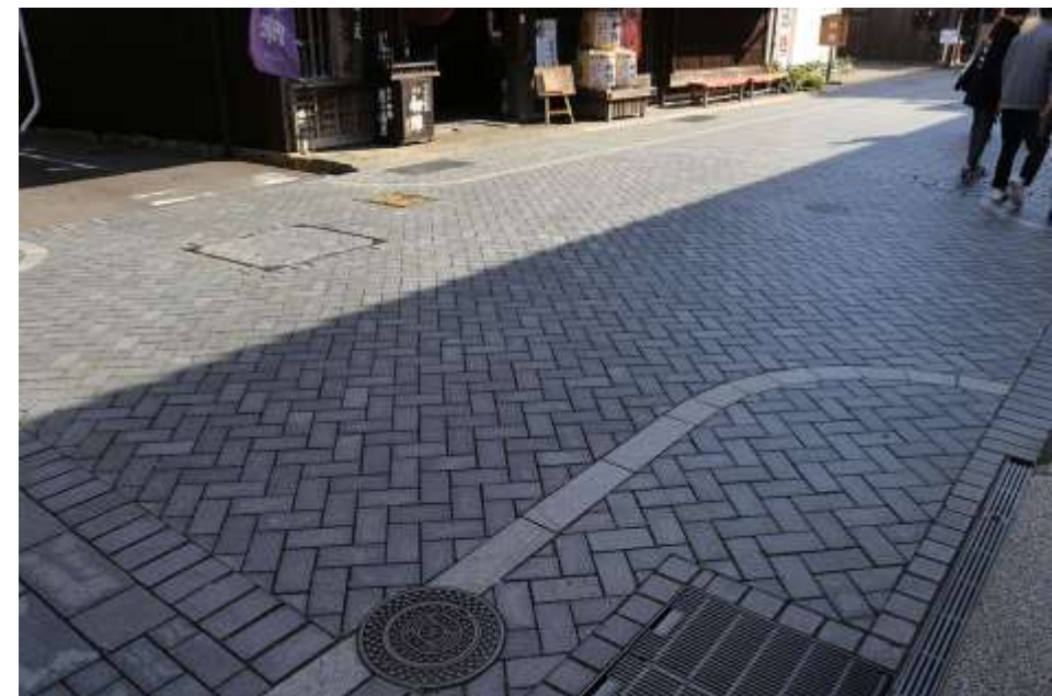
津和野本町・祇園丁通り（津和野町） 交差点部に大型車の展開にも耐える網代貼り（フィッシュボーン）を採用
