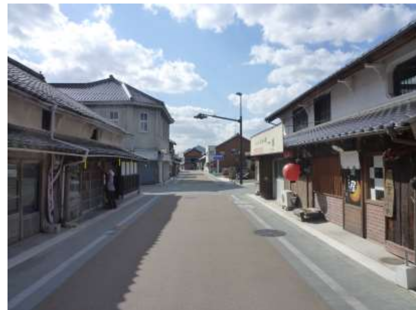
旧山陽道 宮市・国衛地区（防府市） 車道部に路側帯の舗装がにじみ出すように設置
