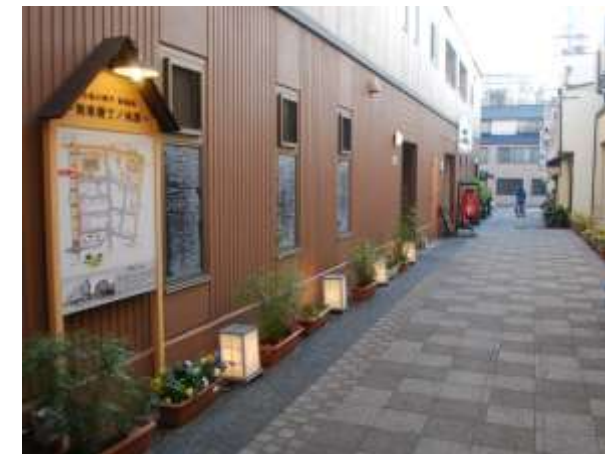
新開地・聚楽横丁（神戸市） 敷地の際だけアスファルト舗装にして 路地の雰囲気を出した舗装
