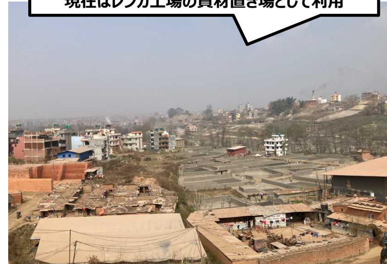
車両基地の設置候補案場所 現在はレンガ工場の資材置き場として利用
