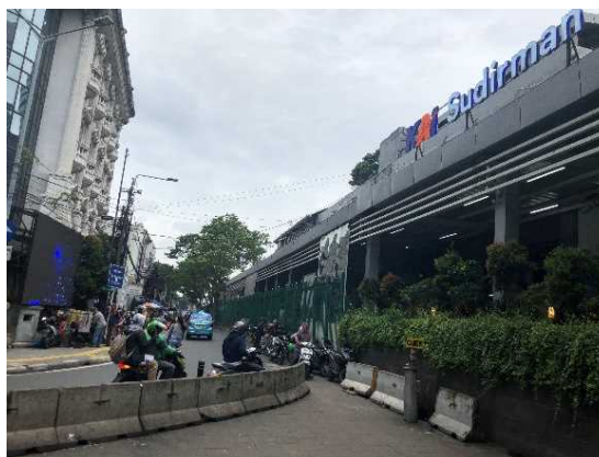
スティルマン駅北側の狭隘道路
