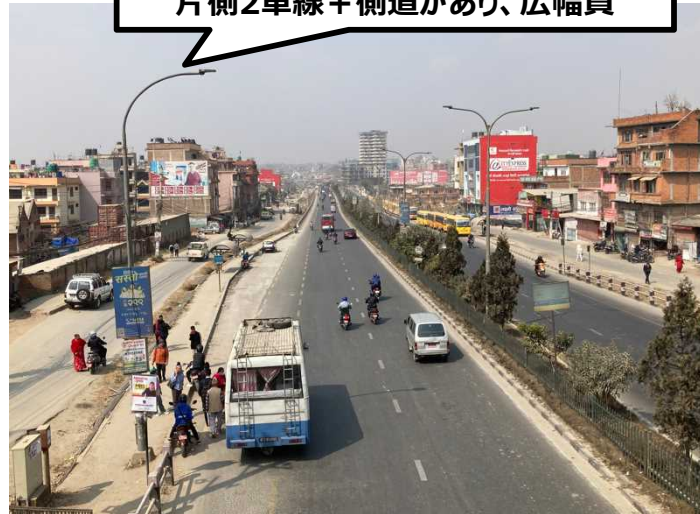
既存道路（Araniko Hw） 片側2車線+側道があり、広幅員
