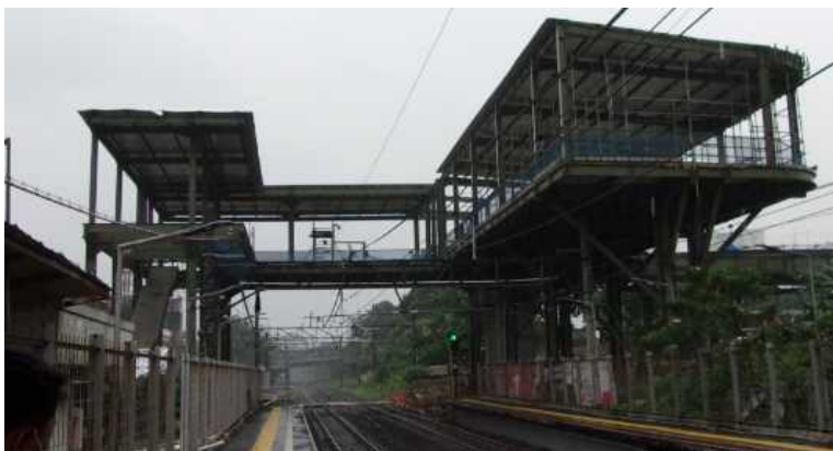
デッキの施工状況(スティルマン駅直上部)
