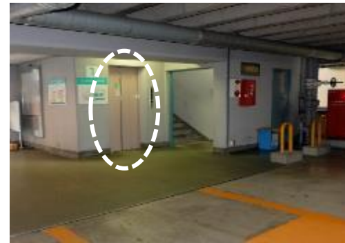
(駐車場にエレベータを設置)
