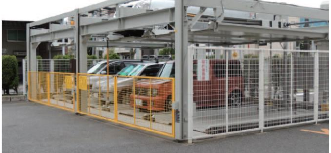
写真：外部者の侵入を防ぐ前面ゲートと柵の設置例
