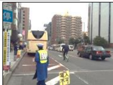
② 交通誘導員の配置
