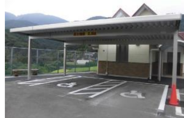
＜車椅子乗降時に雨や雪に濡れないよう、屋根を設置した例＞ (第4回移動等円滑化評価会議資料)
