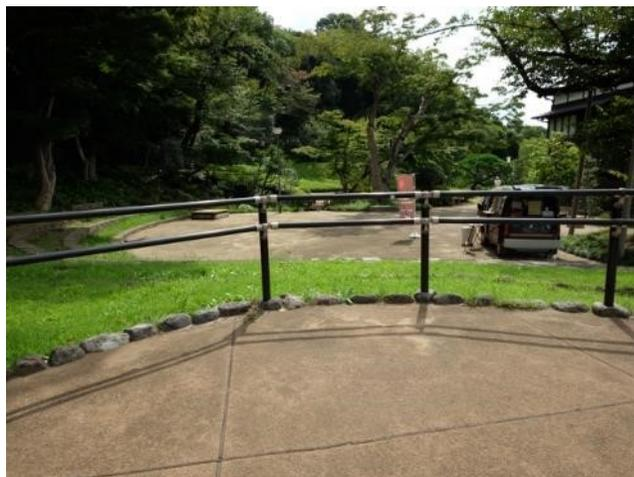
観覧席最上部に車椅子使用者用観覧スペースと斜面スタンドへの転落防止柵を設置。
