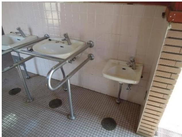
洗面器周りの改修整備により、もたれても丈夫な手すりを設置、子どもの利用に配慮した洗面器を設置。
