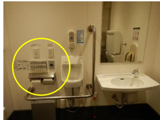
便器の横壁面に紙巻器、便器洗浄ボタン、呼出しボタンを設置する場合は、JISに適合(形状、色、配置)して設置。
