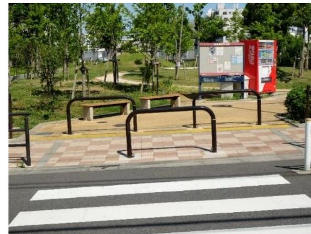
道路への飛び出し防止のため、車椅子等に配慮した広い開口部を確保しながら、公園入口と歩道の両方に車止めを設置。
