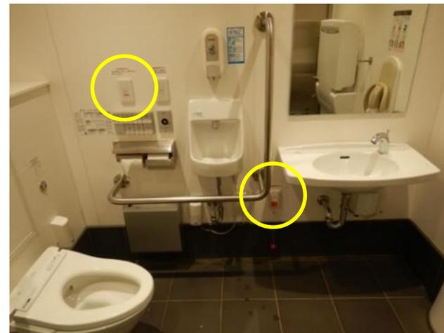
バリアフリートイレ内に手洗い器、洗面器、鏡を設置。呼出しボタンは便器に座った時だけでなく、床に倒れた時にも押せるよう2か所設置。
