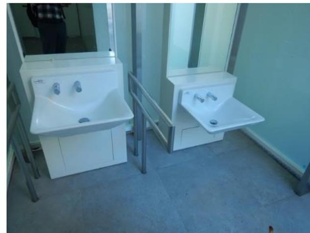
高さの違う洗面器を設置し、洗面器下に車椅子利用者の膝が入るスペースを確保。鏡は車椅子でも立位でも使用できるように縦方向に十分な長さのあるものを設置。
