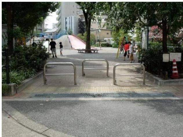
車止めを複数列配置する場合は、飛び出し防止に配慮し、車椅子やベビーカーがスムーズに通行できる開口幅を確保。
