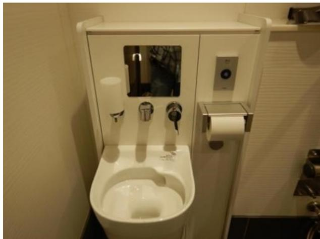
温水が出るオストメイト用水洗器具、腹部を確認するための鏡、ストーマ装具等の小物を置ける棚を設置。
