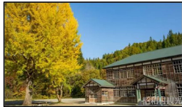
旧喰丸小学校改修工事 (福島県昭和村)
