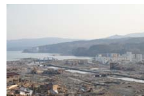
志津川地区の被災状況
