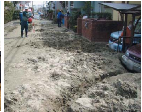
地表に噴き出した噴砂／千葉県千葉市
