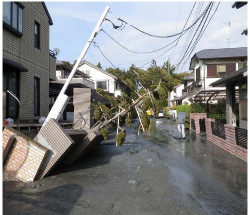
沈下による被害と噴砂／千葉県浦安市
