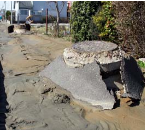
マンホールの浮上がり／千葉県香取市
