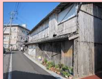
空き家の除却
