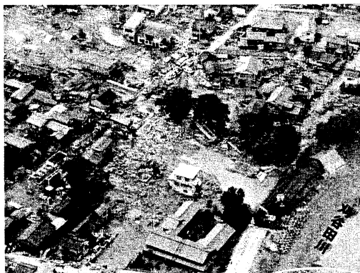
【破堤による被害状況 (H16.7新潟・福島豪雨)】
