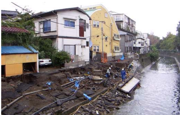
妙正寺川の増水に伴う護岸被災状況 (中野区北原橋付近)
