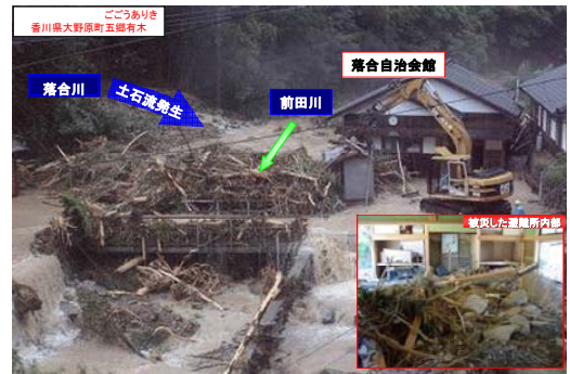
自治会館に避難した住民が被災(香川県)
