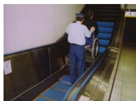
車いす対応エスカレーター
